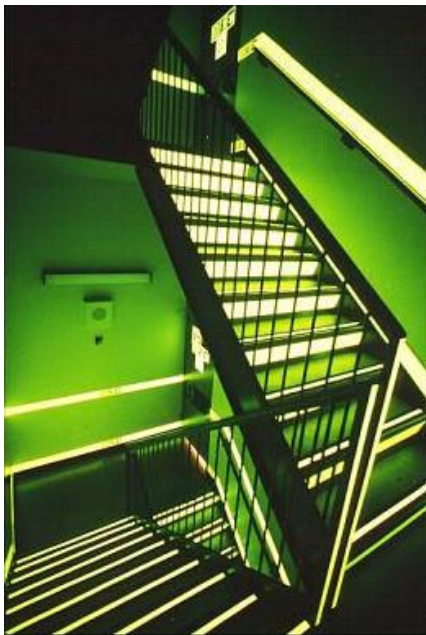
Abbildung 5: Lumineszierender Weg in einem Treppenhaus bei Dunkelheit
